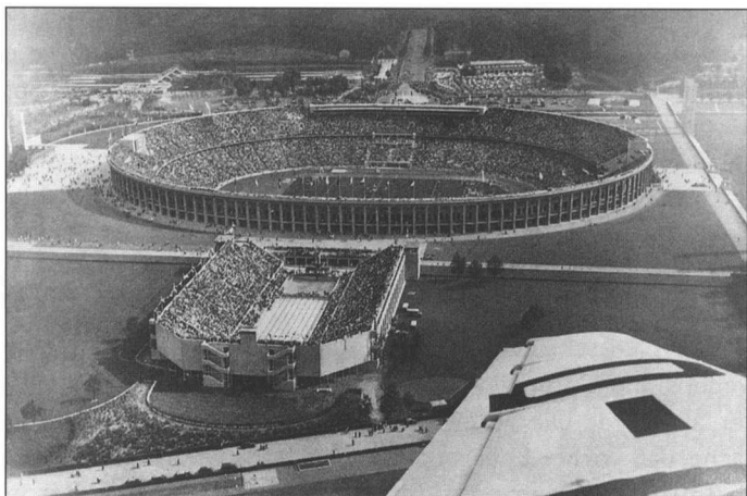
1936: Blick auf das Olympiastadion und das Schwimmstadion
